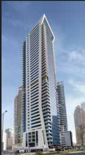
AL DAR TOWER Appartements de vacances
