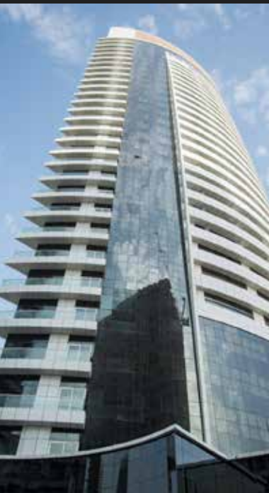
THE BRIDGE Tour Résidentielle
