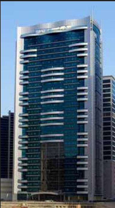
FIRST CENTRAL Appartements De L'hôtel
